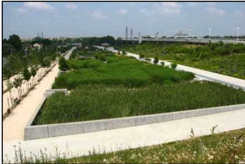
شکل پ.۴-۱۶- تصویری از نمونه اجرا شده یک سیستم گیاه‌پالایی با تالاب مصنوعی
